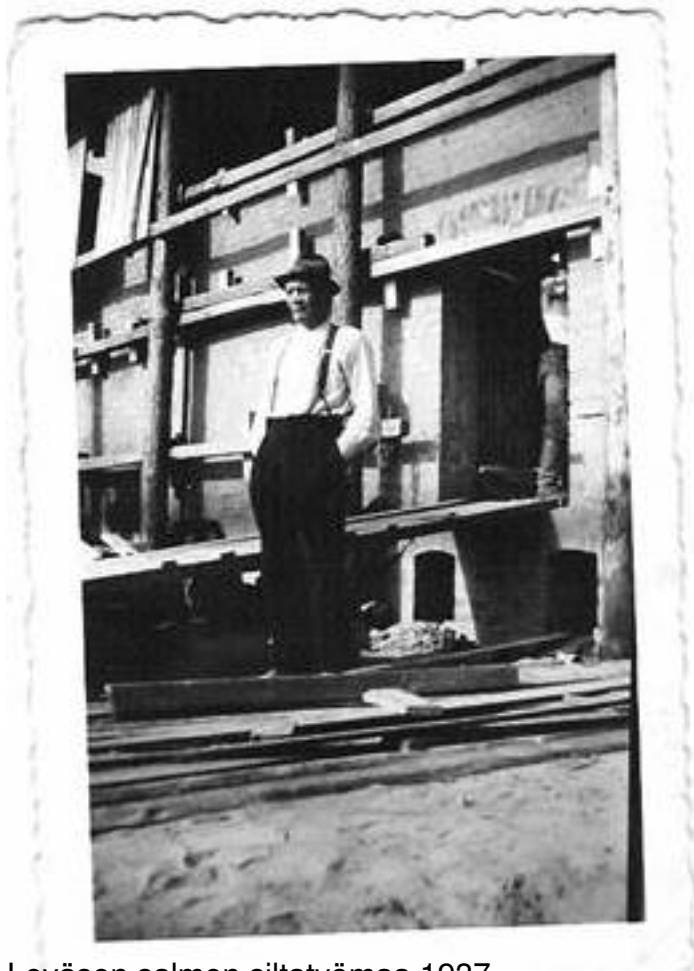
Leväsen salmen siltatyömaa 1937
